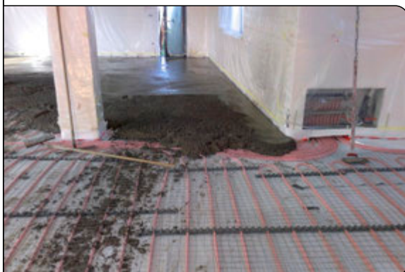
Estricheinbringung auf dem MB-System
