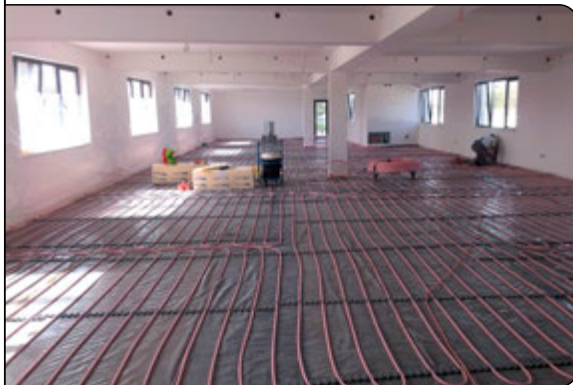
verlegtes MB-Estrichsystem
