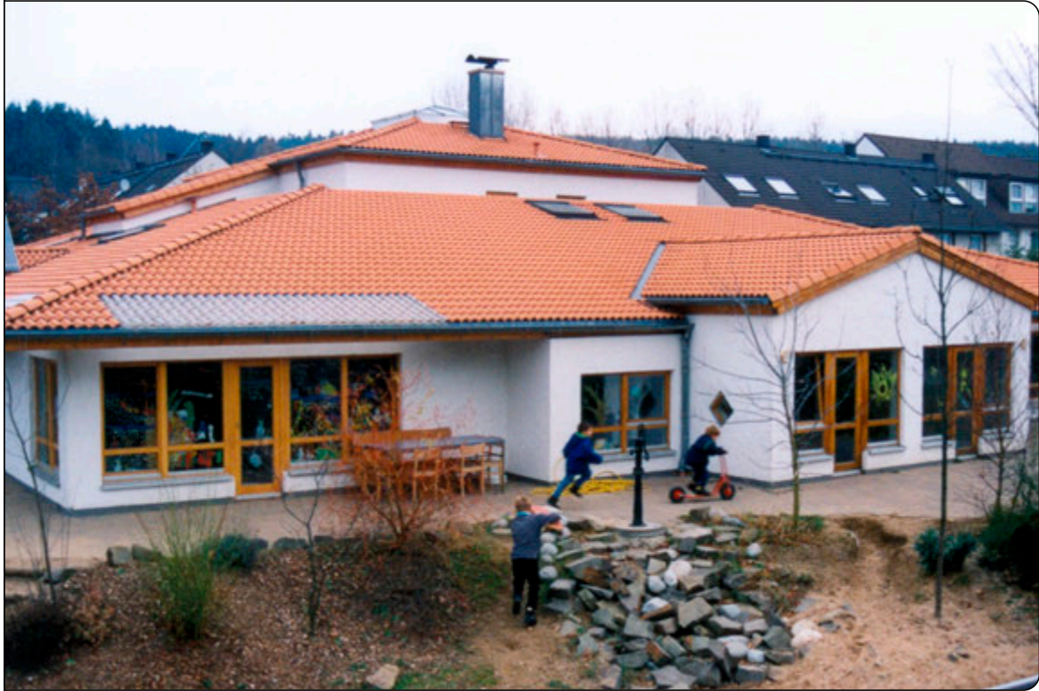
Außenansicht Murkel I
