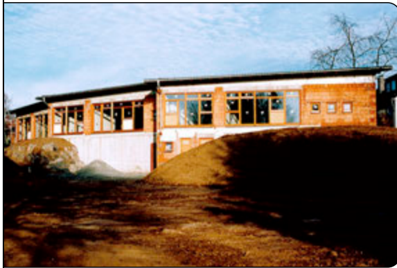
Murkel II im Bau
