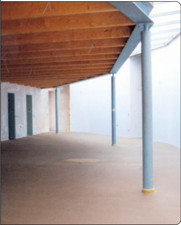
Murkel II, Innenansicht nach der Estrichverlegung
