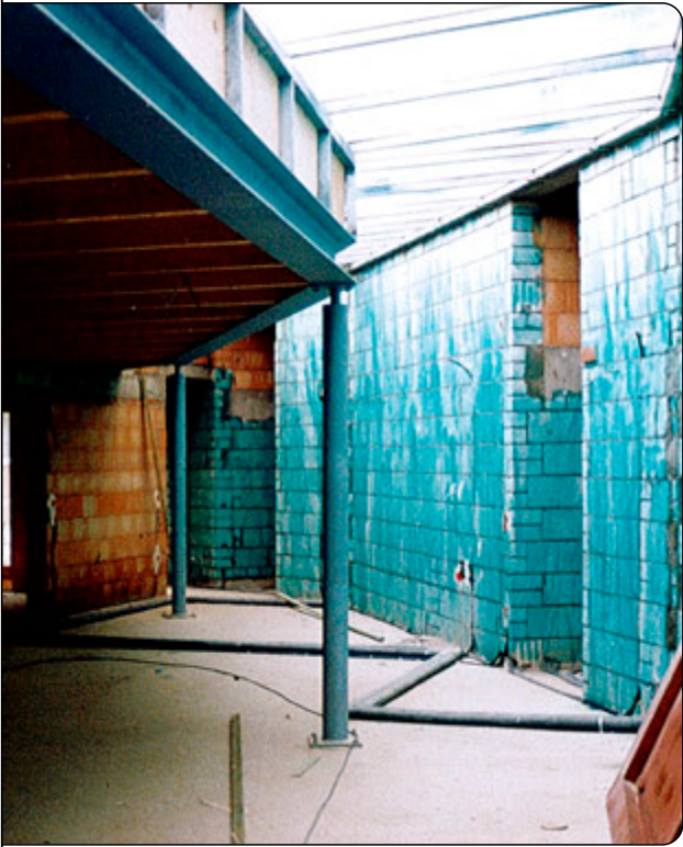
Murkel II, Innenansicht Rohbau
