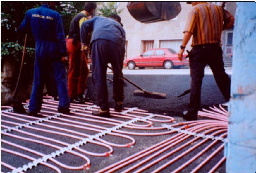
Einbringung des Asphalts
