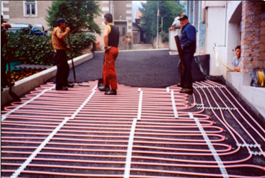
Asphalt auf MB-System
